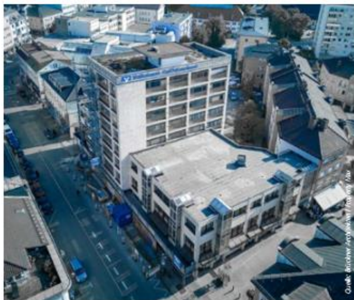
Eigentlich sollte der alte Komplex komplett abgerissen werden
